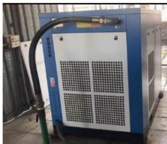
2台 55kW 永磁電機及變頻功能的節能螺桿空氣壓縮機
